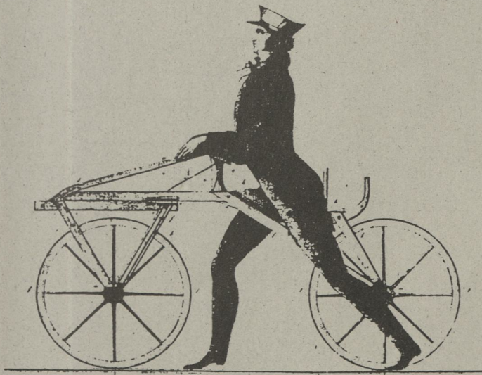
Bild 1 : Aus der Patentschrift des Freiherrn von Drais aus dem Jahre 1818
