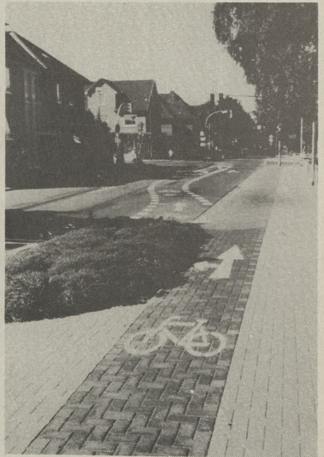
Abb.14: Linksabbiegestreifen für Fahrradfahrer an lichtsignalgesteuerter Kreuzung
