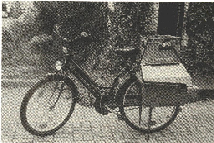
Mit dem Gepäckträgersystem ist auch der Transport von sperrigen Gütern einfacher als auf herkömmlichen Gepäckträgern. Kleinere Gepäckstücke verschwinden in den seitlichen festen Taschen. Das ganze System ist abschließbar.
