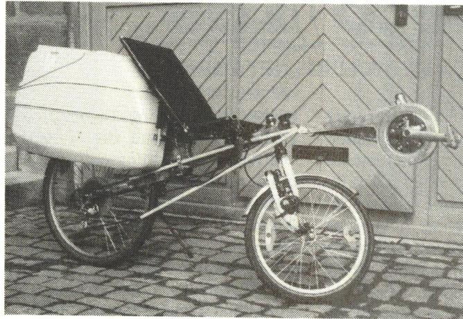
ne spezielle Aufhängung entwickelt. Insgesamt ist die Firma SCHÜMO bereit, auch auf andere Sonderwünsche einzugehen. Konstruktionsbedingt ist der Laderaum durch das Hinterrad geteilt. Besonders sperrige Güter, wie Getränkekästen, lassen sich nicht im,
