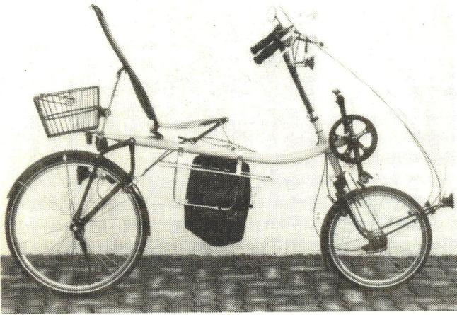
Es gibt zwei Arten von Liegerädern, die langen und die kurzen. Sie unterscheiden sich durch die Lage des Tretlagers, bei den ersteren liegt es hinter, bei dem letzteren vor dem Vorderrad, das lange ist ein gutes Reiserad ("Länge läuft"), das andere ein wendiges und schnelles Sportgerät. Dies scheint die herrschende Lehre im Liegeradbau zu sein. Die einzelnen Modelle unterscheiden sich nur noch in technischen Raffinessen und diversen **Ausstattungsmerkmalen**.
