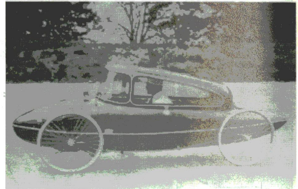
Bild 4: „Landskiff“, ein Velomobil mit Ruderantrieb von Manfred Curry aus dem Jahr 1926
